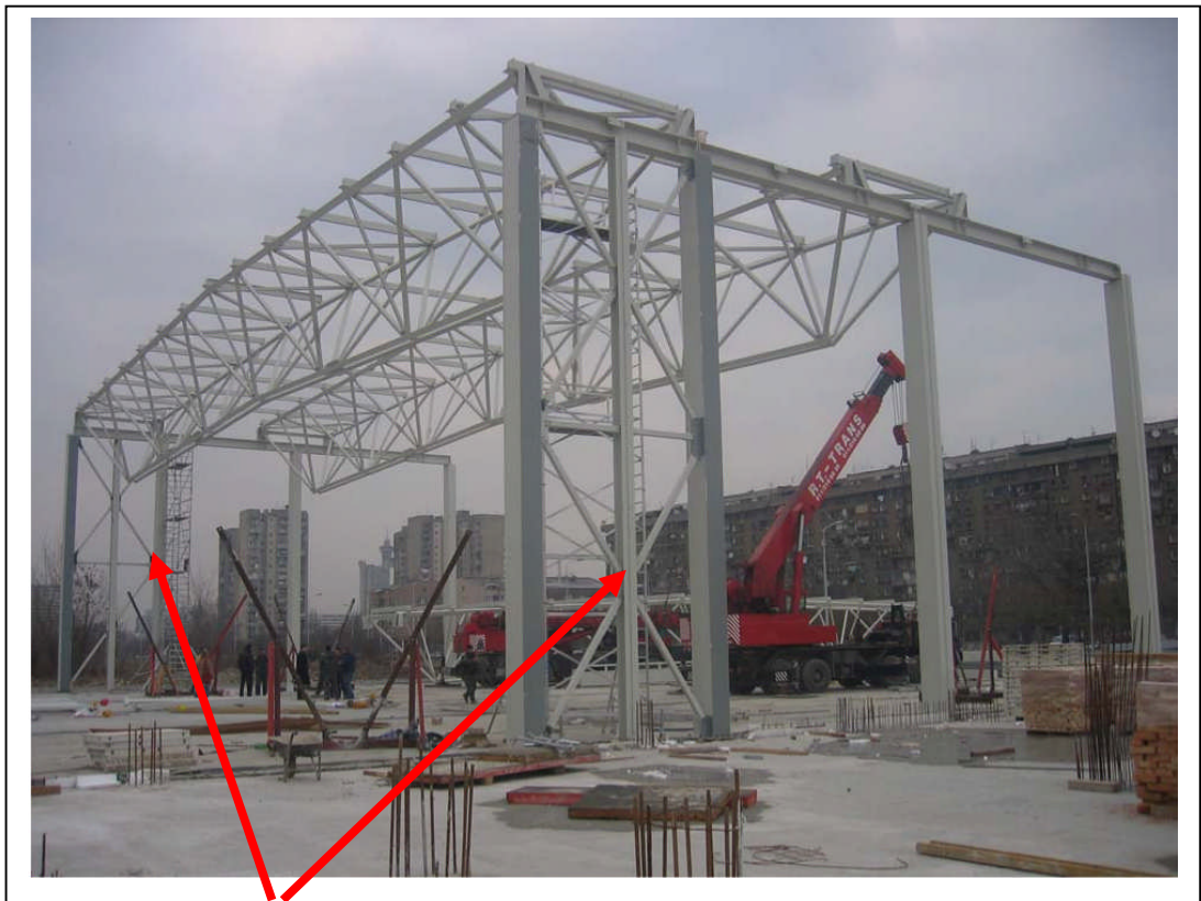
Vertikalni spreg u podužnom zidu
